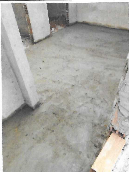
Imagem 05 – Contrapiso em argamassa traço 1:4 (cimento e areia), preparo mecânico com betoneira 400 l, aplicado em áreas secas sobre laje, aderido, acabamento não reforçado, espessura 2cm - Bloco Vestiário de Times.
