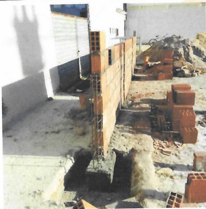
Imagem 18 - Concreto magro para lastro, traço 1:4,5:4,5 (em massa seca de cimento/ areia média/ brita 1) - preparo mecânico com betoneira 400 l - Portal de Entrada.
