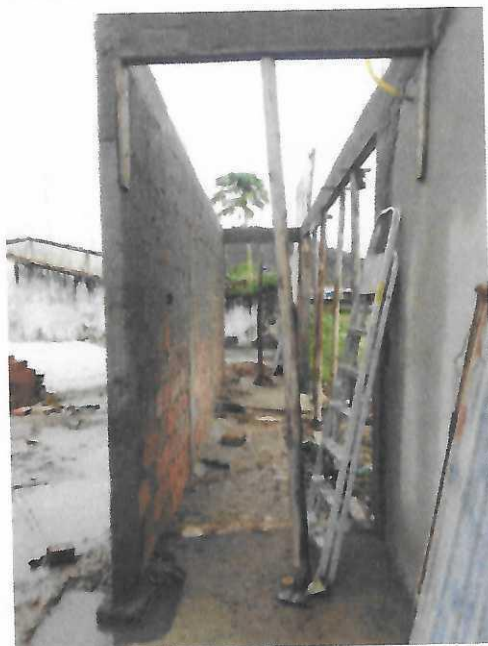
Imagem 22 - Concreto Armado fck=21,0Mpa e Chapisco em parede com argamassa traço t1 - Portal de Entrada.
