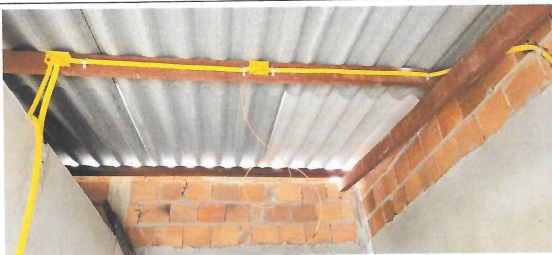
Imagem 13 - Ponto de luz em teto ou parede, com eletroduto de pvc flexível sanfonado embutido Ø 3/4" - Bloco Vestiário de Times.
