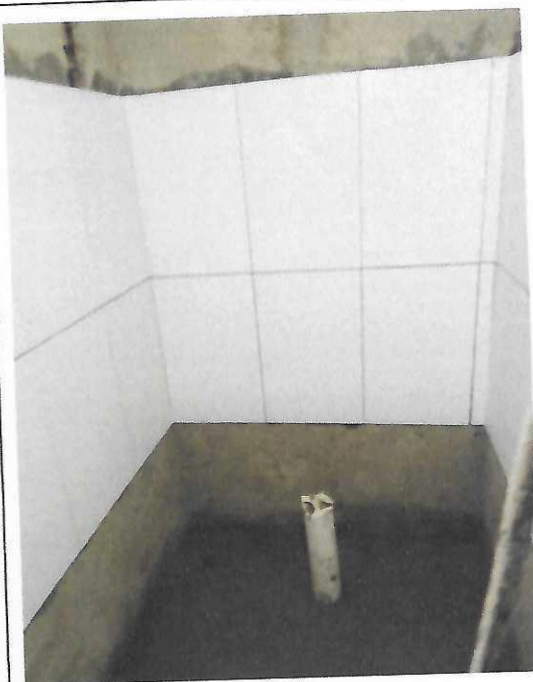
Imagem 02 – Revestimento ceramico para parede, 15 x 15 cm, azulejo branco, tipo "A", aplicado com argamassa industrializada ac-i, rejuntado, exclusive emboço - Bloco Vestiário de Times.
