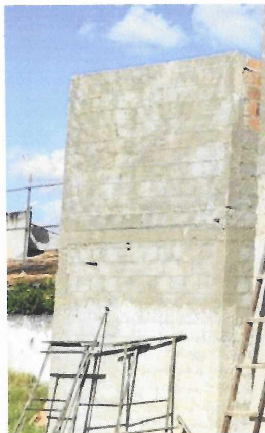
Imagem 15 - Chapisco em parede com argamassa traço t1 - 1:3 (cimento / areia ) - Revisado 08/2015 - Fosso da Caixa d'água.
