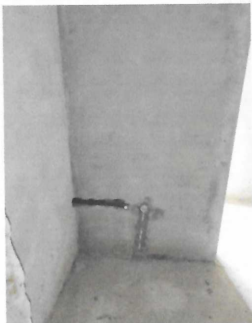
Imagem 7 - Ponto de água fria embutido, c/material pvc rígido soldável Ø 25 mm - Bloco Vestiário de Times.
