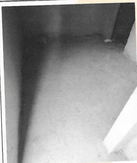
Imagem 04 – Contrapiso em argamassa traço 1:4 (cimento e areia), preparo mecânico com betoneira 400 l, aplicado em áreas secas sobre laje, aderido, acabamento não reforçado, espessura 2cm - Bloco Vestiário de Times.
