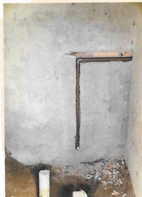
Imagem 8 - Ponto de água fria embutido, c/material pvc rígido soldável Ø 25 mm - Bloco Vestiário de Times.
