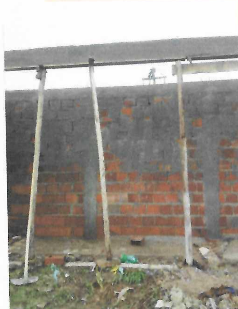
Imagem 23 - Concreto Armado fck=21,0Mpa e Chapisco em parede com argamassa traço t1 - Portal de Entrada.
