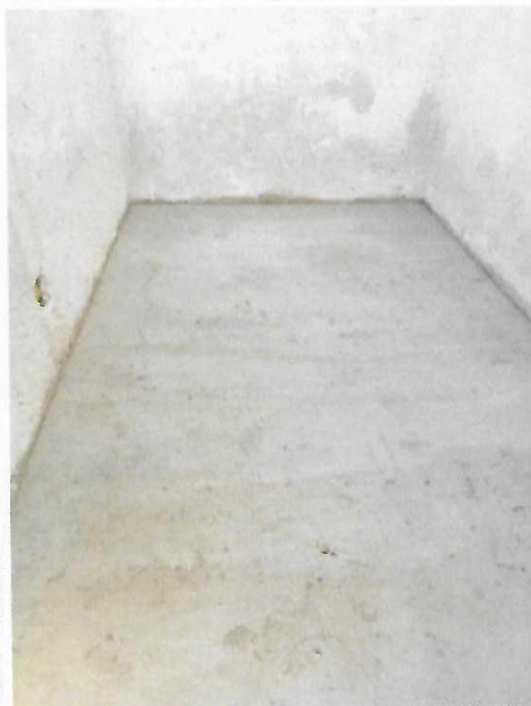
Imagem 06 – Contrapiso em argamassa traço 1:4 (cimento e areia), preparo mecânico com betoneira 400 l, aplicado em áreas secas sobre laje, aderido, acabamento não reforçado, espessura 2cm - Bloco Vestiário de Times.
